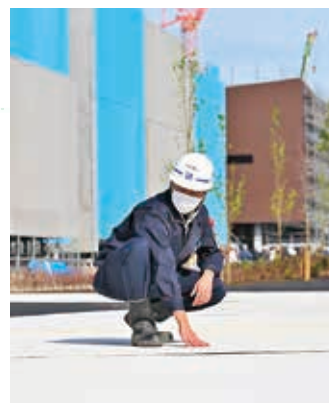
引き渡し前にコンクリートの出来栄を最終確認
