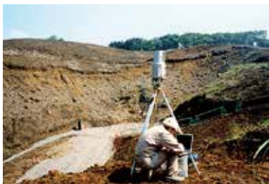
3次元レーザスキャナによる地形測量例
