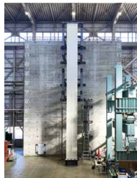
最大高さである12mのパネル設置状況
