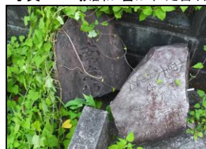
写真-5 破損した旧碑
