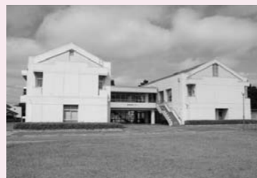
図-1 測量実習センターの外観
