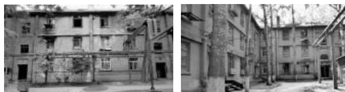
Fig.4 写真 ix街区 北側 写真 i街区 東側
