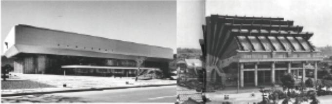
Fig. 5 菊竹による上下構造を分離したメタボリズム
