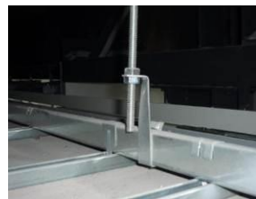
Figure1-1 ハンガーの変形
