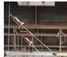
Figure 3-8 制震ダンパーの取付
