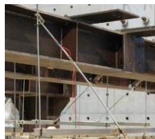
Figure 3-12 チャンネルホルダーの外れ
