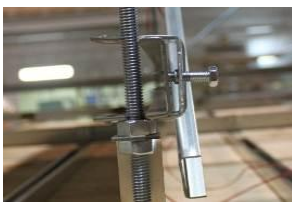
Figure 3-12 チャンネルホルダーの外れ
