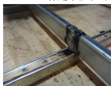
Figure 3-2 溶接後のクリップ・野縁受け
