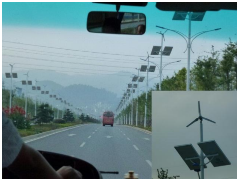
写真1 臨ソウ市街地の風力及び太陽光システム。
