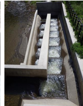
a) 摺淵床固め工に設置された魚道 b) 南郷床固め工に設置された魚道 c) 相川川砂防堰堤の魚道
