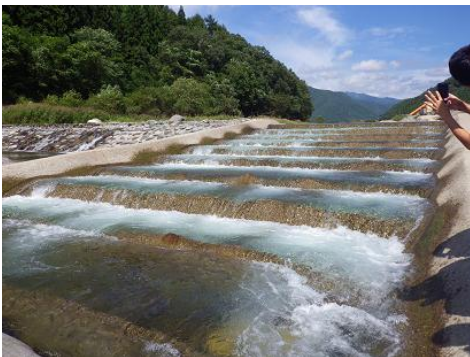
a) 摺淵床固め工に設置された魚道 b) 南郷床固め工に設置された魚道 c) 相川川砂防堰堤の魚道
