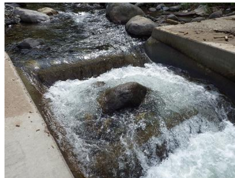
a) 摺淵床固め工に設置された魚道 b) 南郷床固め工に設置された魚道 c) 相川川砂防堰堤の魚道
