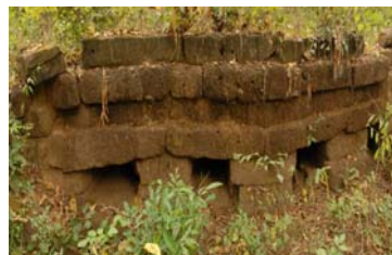
写真 2 Dルートの桁橋
