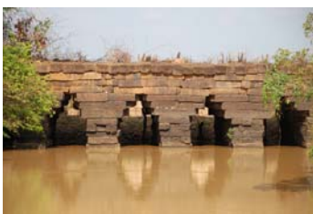
写真 1 Bルートの 迫出しアーチ橋
