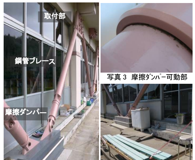
写真2 制震ブレース取付状況
