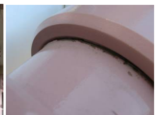
写真3 摩擦ダンパー可動部
