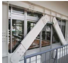
写真8 ダンパー取付状況
