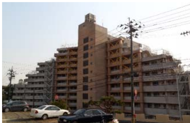
写真 5 被災した仙台市の高層住宅の外観
