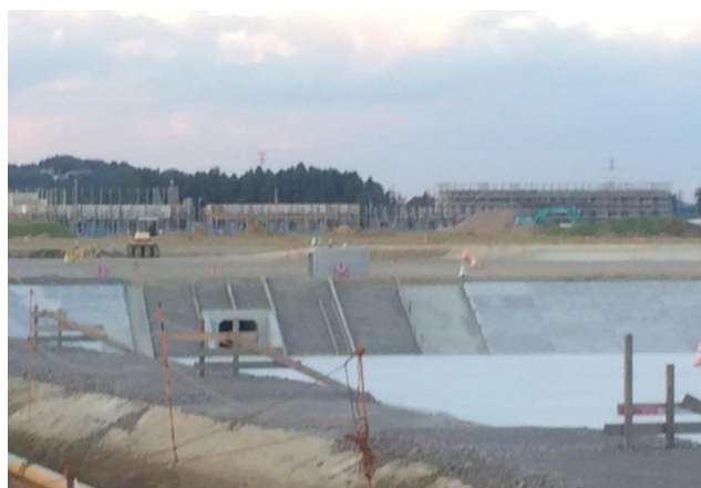
写真 1 新蛇田地区造成の様子
