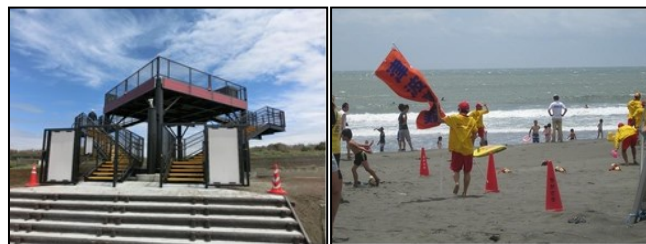
写真-1. 津波避難タワー 写真-2. 避難訓練
