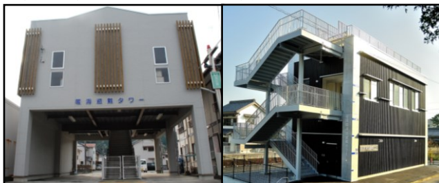
写真-5 備蓄倉庫
