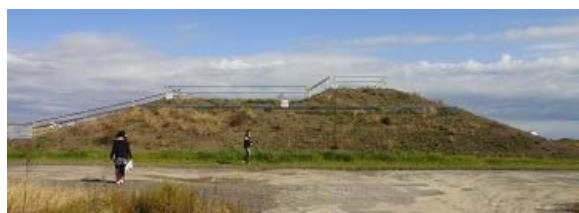
写真6 嵩上げ地盤の試験造成 (名取市)
