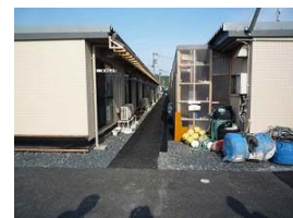
写真5 傾いた仮設住宅
