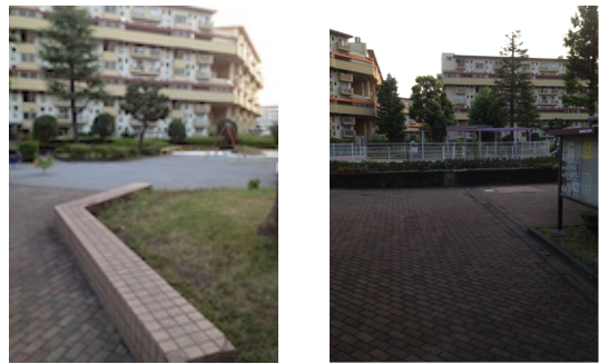
fig.4 奈良北団地内の様子(筆者撮影 2015.08.15)
