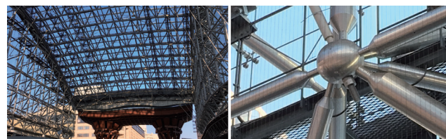
(a) 金沢駅もてなしドーム (b) 立体トラス詳細
