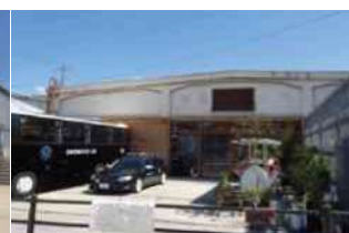
写真2 県営2号上屋（尾道糸崎港）の西面妻入り側の搬入口 [筆者撮影/撮影日: 2017.9.2]
