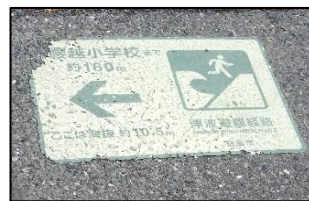
写真 1. 路面が透過し見づらい路面シート
