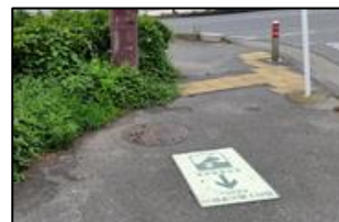
写真 3. 樹木による視認阻害
