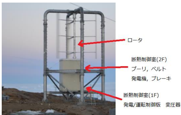
Figure1 The actual Syowa wind power generator
