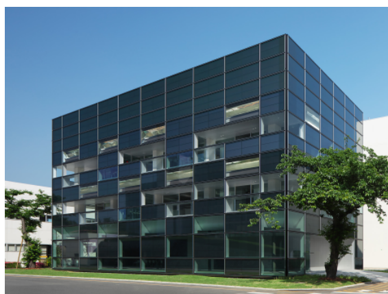
写真 1. BIPV 使用例 大成建設技術センター ZEB 棟
