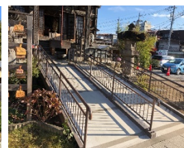
写真4 正面アプローチを階段からスロープに変更している。
