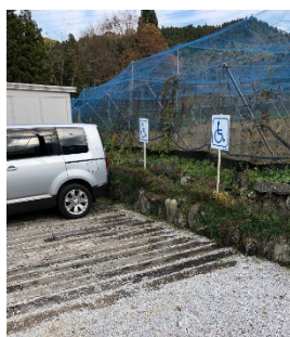
写真2 駐車場の砂利敷きに枕木を埋め込み路面を平坦にしている。
