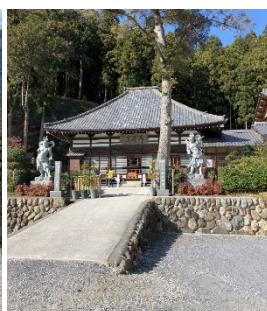
写真3 スロープを設け横の仕上げを石垣に合わせ意匠に配慮している。
