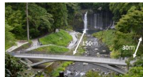
Figure - 1 滝見橋の架橋位置
