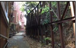
写真4 避難路改修(3) [参考文献 2) より引用]
