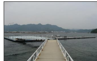
写真-3: 突堤先端の釣り桟橋と係留施設(ヒューマンビーチ長瀬)
