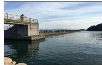
写真-1: 離岸堤に橋を架け釣場として開放している事例(大島漁港)
