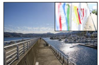
写真-6: 背後が商業施設の遊歩道(伊東マリンタウン)
