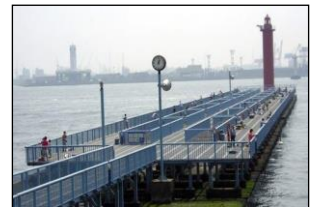
写真-4: 防波堤上の釣り桟橋(大黒海づり施設)
