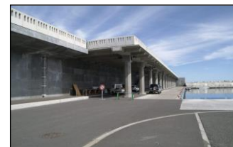
写真-5: ドーム上部が遊歩道の防波堤(宗谷港)
