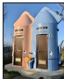
写真-1. イカの形の公衆トイレ（初島）
