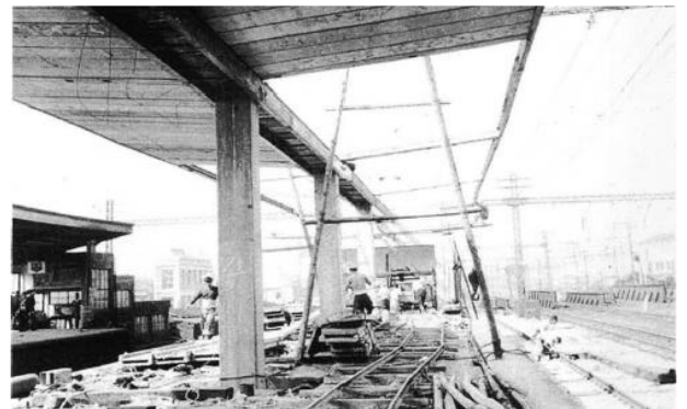
写真1 建設時の状況
