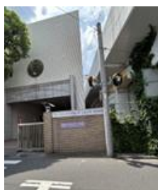
写真3 学校 校舎の一部分が高架下に喰い込んでいる
